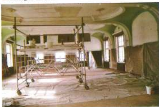
Ehemaliges Schwesternrefektorium und Schulsaal
