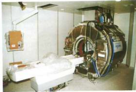
Der Magnet in der fertigen MRT-Kabine. Installation der Bauteile und Vorbereitung der Inbetriebnahme.
