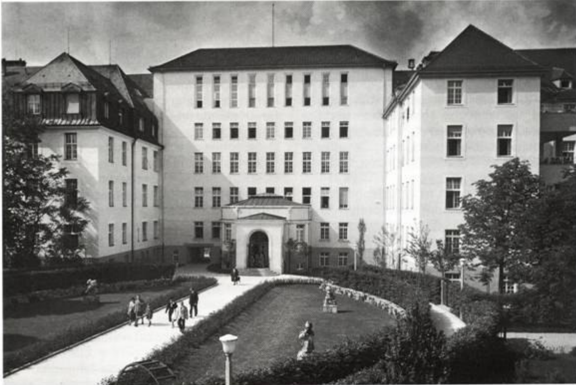
Der 1938 errichtete Mittelbau mit dem Hörsaal im 5. OG.
