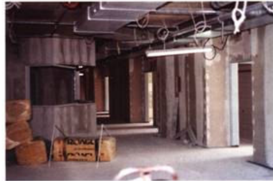
Ein noch im Bau befindlicher Stützpunkt für das Pflegepersonal im 1. Obergeschoss (Stand: Oktober 2000)
