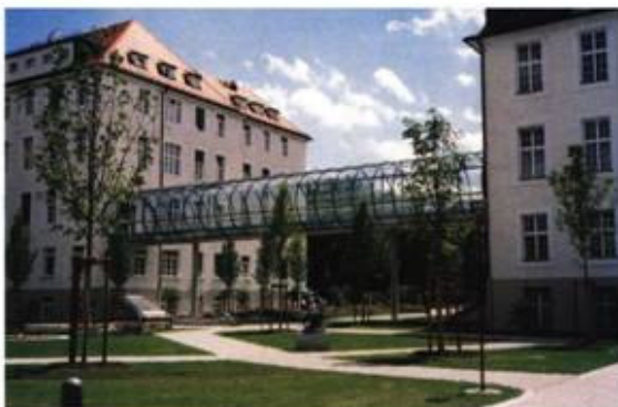
Neuer Übergang vom renovierten Bau 1912 zum Krankenhaus
