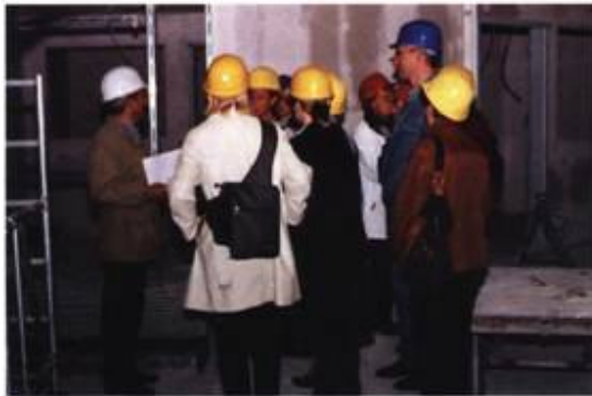
Herr Köhler, Verwaltungsdirektor des Krankenhauses Dritter Orden, führt Mitarbeiter durch den Rohbau der neuen Kinderklinik.
