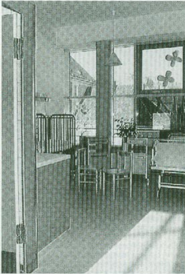
Rooming-in-Zimmer mit Sanitärzelle
