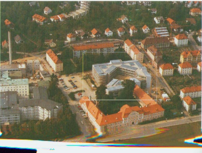
Bildmitte: Der gegenwärtige Stand der Baumaßnahme «Kinderklinik» (Freig. I.A Südb. G. 47/25)
